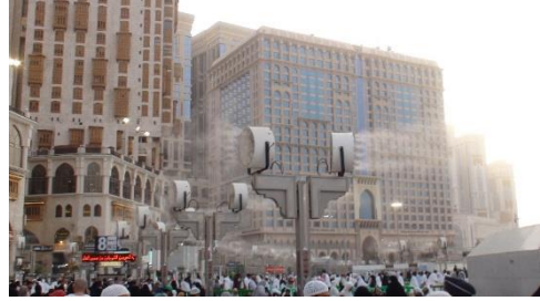
شكل (١): الرشاشات الرذاذية بساحات الحرم المكي.
