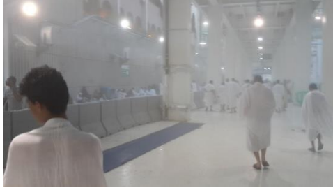
شكل (١): الرشاشات الرذاذية بساحات الحرم المكي.
