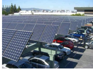
شكل (٤) استخدام الخلايا الشمسية كمظلات
