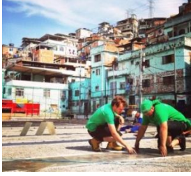
شكل (١١) اثناء تركيب الوحدات
