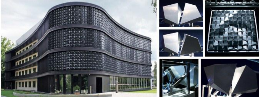
شكل ٢٦: يوضح ديناميكية الحركة في مبني فليير ويتحكم من خلال الحركة المتراكبه للواجهه الخارجيه في ادخال الكميه المناسبه من ضوء النهار
