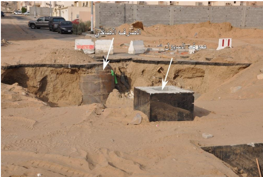
شكل رقم ١٤: صورة فوتوغرافية توضح الهيكل الخرساني لمجرى السيول تحت السطحي جنباً إلى جنب مع خطوط الصرف الصحي كمنظومتين منفصلتين تماماً.
