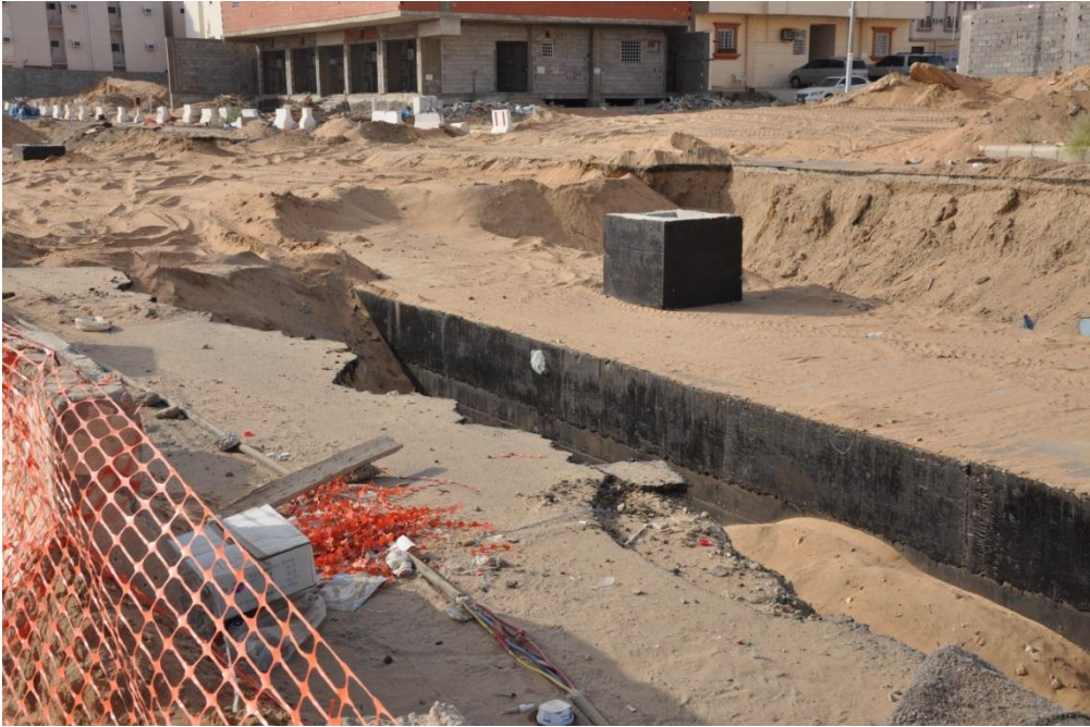
شكل رقم ١٦: صورة توضح الفتحات الصغيرة والضيقة في أعلى منتصف قنوات صرف السيول.
