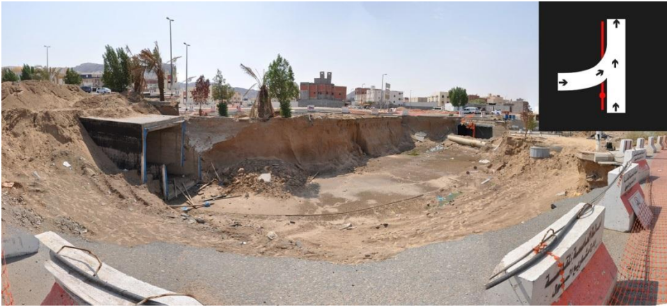
شكل رقم ١٢: بانوراما فوتوغرافية لأحد مخرّات السيول تحت السطحية (تحت الإنشاء) في حي بطحاء قريش بمكة المكرمة. الشكل في الركن العلوي الأيمن من الصورة هو عبارة عن رسم توضيحي لمنظر علوي لمحتوى الصورة الفوتوغرافية (الخط الأحمر هو ماسورة الصرف الصحي).
