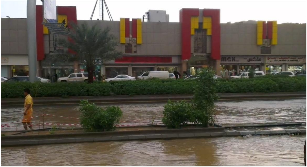
شكل رقم ٨: صورة فوتوغرافية لجزء من شارع العزيزية العام (الصورة يظهر بها مبنى سوق العزيزية) بعد العاصفة الممطرة ليوم الجمعة ٢٨ ديسمبر ٢٠١٢م (١٥ صفر ١٤٣٤ هـ)، والتي يظهر بها امتلاء الشارع بمياه المطر وعدم تصريفها بشكل مباشر وسريع في مصارف السيول المغطاة (أسفل الطريق) بالمنطقة.
