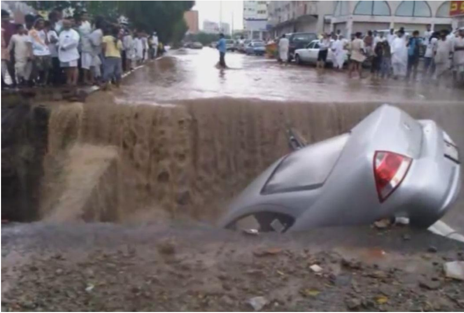
شكل رقم ٦: صورة فوتوغرافية توضّح انهيار جزء من شارع الحج الناتج عن النحر التحت سطحي للمياه المتساقطة في يوم الخميس الموافق ٣٠ ديسمبر ٢٠١٠م (٢٤ محرّم ١٤٣٢هـ).
