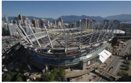
مراحل إنشاء التغطية النسبجية من طبقة واحدة والأعمدة والكابلات الحاملة لها.
