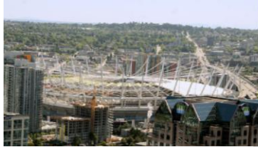
مراحل إنشاء التغطية النسبجية من طبقة واحدة والأعمدة والكابلات الحاملة لها.
