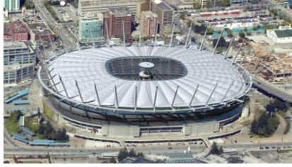
Buildings in hurricane-prone إمكانية امتداد الأنابيب الهوائية لعشرات الأمتر بدون أى مرتكزات بالوسط مع توفير عنصر الأمان للمنشأ.
