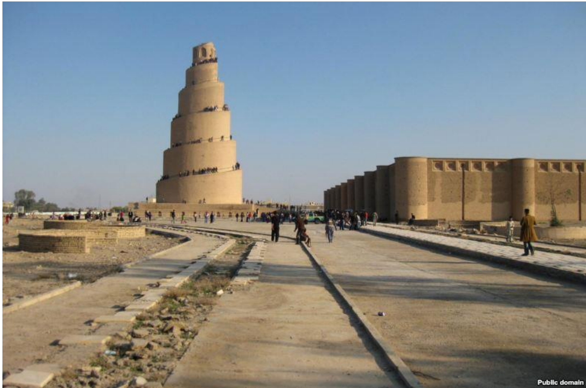
الصورة رقم (٦): ملوية سامراء الشهيرة شمالي بغداد المصدر: الباحث.
